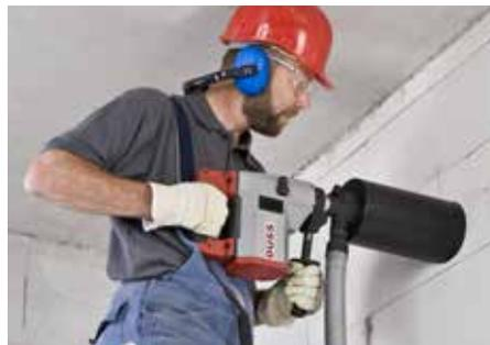
Trockenbohren in Mauerwerk mit Staubabsaugung, handgeführt
