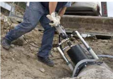
Anbohren von Betonrohr – nass, stativgeführt
