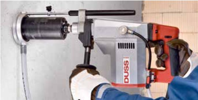
Dosensenken nass in Beton mit Wasserabsaugung
