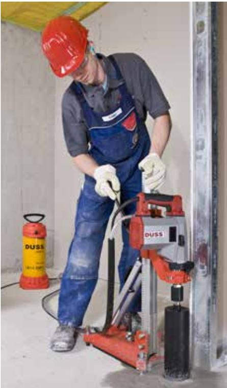
Nassbohren in Beton, ständergeführt
