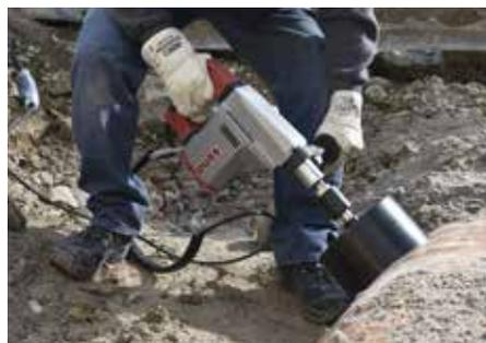
Anbohren von Kunststoffrohr – trocken, handgeführt
