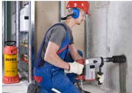
Dosensenken in Beton – nass, handgeführt
