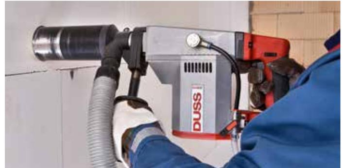
Dosensenken trocken in Kalksandstein mit Staubabsaugung
