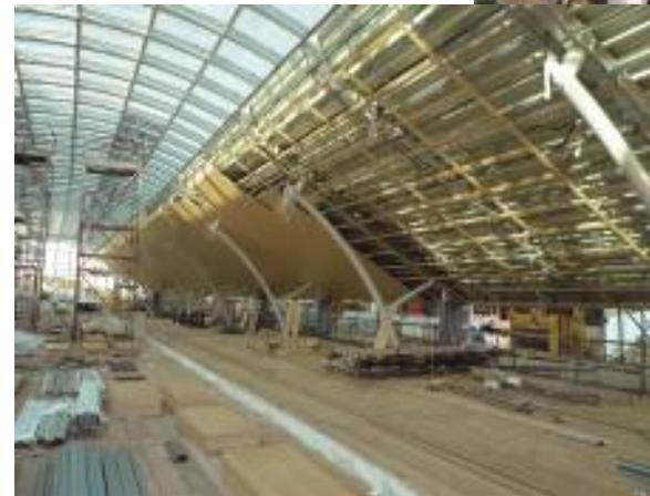
As peças portantes para o revestimento dos telhados com painel ignífugo, são compostas de quadros de construção clássicas.
